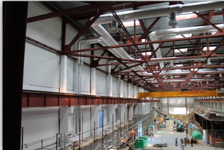
Подготовка к монтажу уникального оборудования
